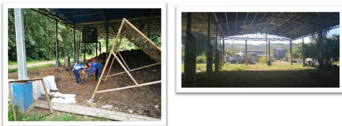
Ilustración 5. Planta de compostaje de la Municipalidad de Pérez Zeledón, a la izquierda las instalaciones actuales y a la derecha la ampliación de la infraestructura
